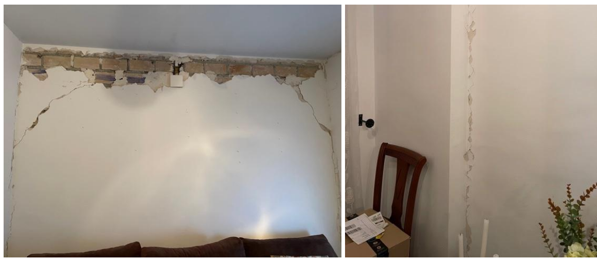
Figura 5. Daños observados en la población de Atarfe tras el terremoto de Mw 4,4 del 23/01/2021.
